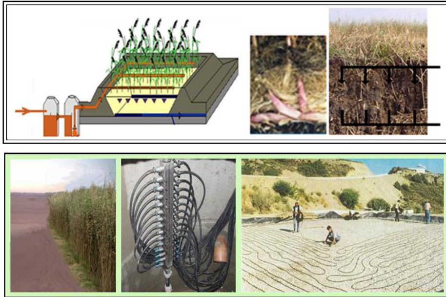
كيفية مد شبكة توزيع مياه الصرف في حوض المعالجة للطريقة الرطبة SFS
