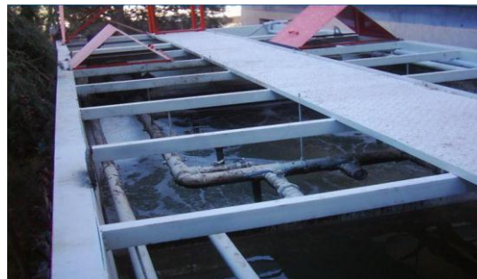
محطة معالجة مبيدات حشرية كومباكت بالحماة المنشطة التهوية المديدة في سورية - حلب
