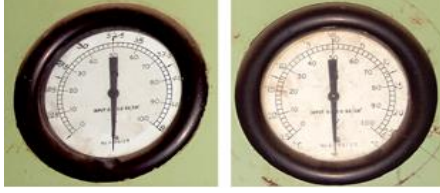
مقياسي الضغط ودرجة الحرارة المعاندين للخران المنكوب ويوجدان في غرفة التحكم.
