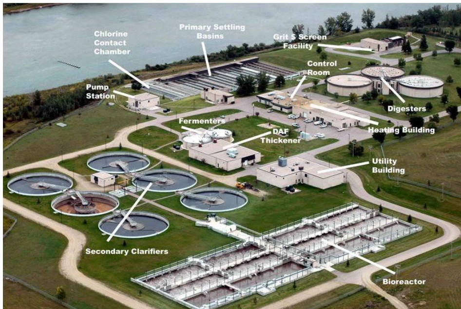
الشكل ١٠٣: مصور محطة معالجة مياه صناعية
